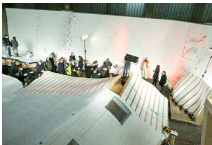
In einer Montagehalle wurden für das Blatt 117 Holz- und Styroporelemente – 6 bis 17 m 2 groß – gefertigt. Foto: Bregenzer Festspiele/Dietmar Mathis
