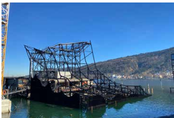
Muss zwei Jahre lang Wind und Wetter trotzen: die fachwerkartige Unterkonstruktion aus Stahl. Foto: Bregenzer Festspiele/Lisa Mathis
