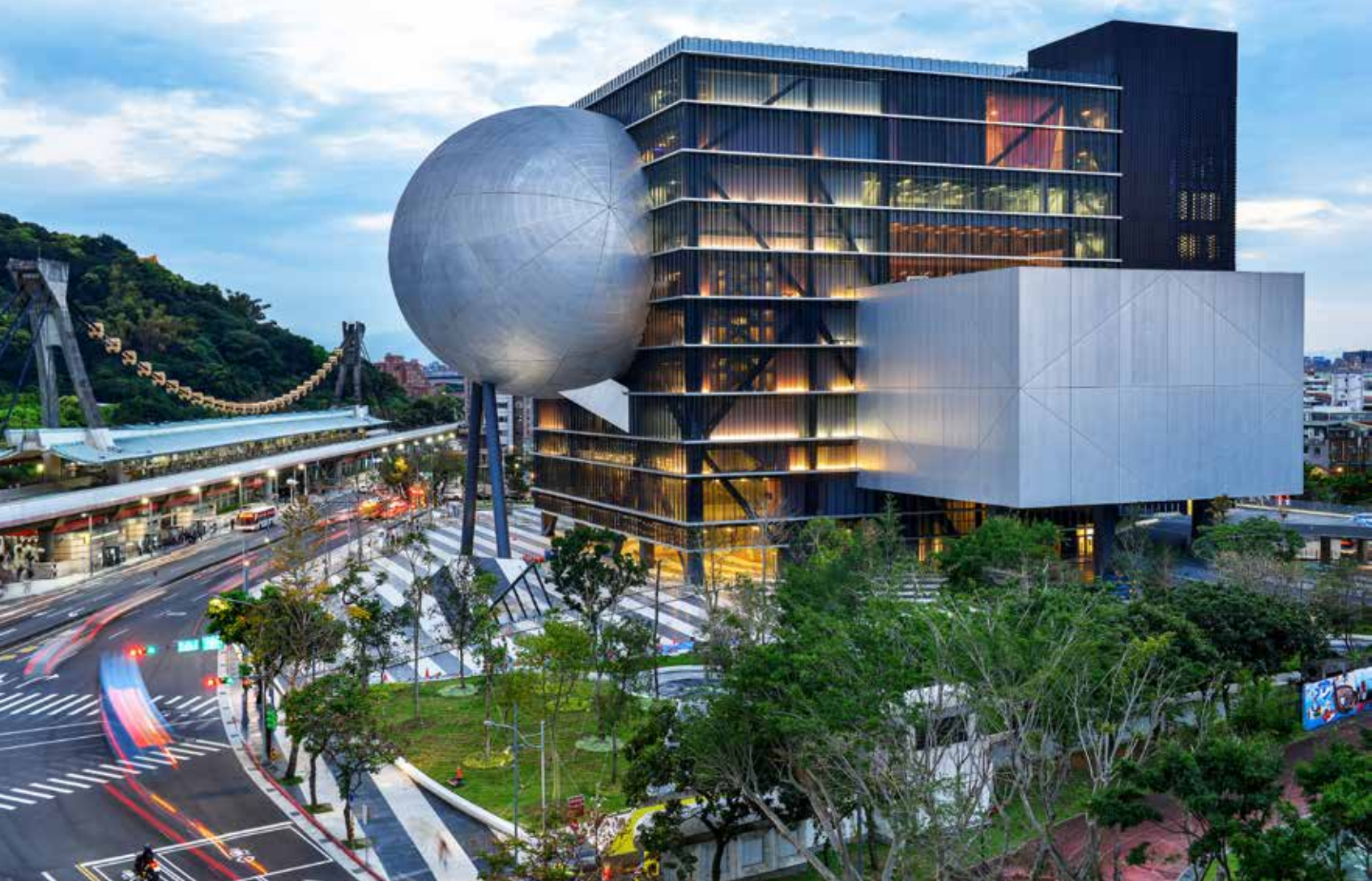
Markanter Bau: Die drei Säle des TPAC sind an einen zentralen Kubus angedockt. Fotos: DMA Photography by Chris Stowers (4)
