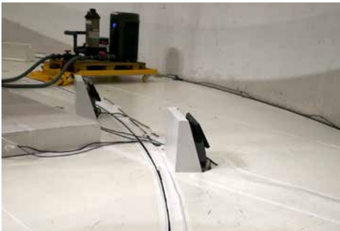
Wasserschutz: Auf dem Festland ist umlaufend unter dem Tanzteppich ein Tau verklebt; hinten eines der drei Heiz-Filter-Systeme für Aquarien und Pool
