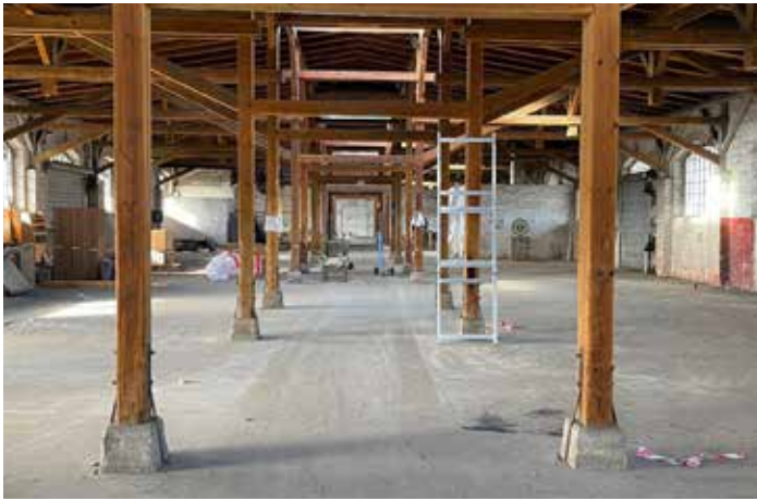
Auf 2500 m 2 wurden die detailreichen Spielräume in dem alten Gebäude eingebaut. Vorhandene Seitentüren dienten zur Entfluchtung
