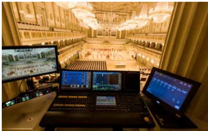
Elementar war die Modernisierung der Tonregietechnik inklusive digitalem Mischpult und Audiosignalverarbeitung im Großen Saal. Foto: Florian Kresse
