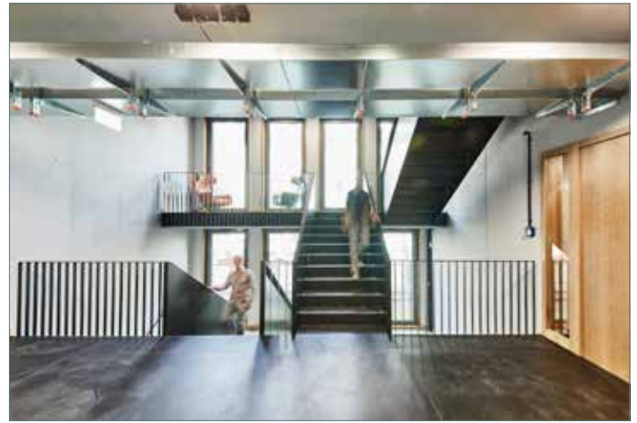
Die Oberflächenmaterialien sind aus robustem Beton, Holz und Stahl und lassen sich mit geringem Aufwand aufarbeiten oder erneuern
