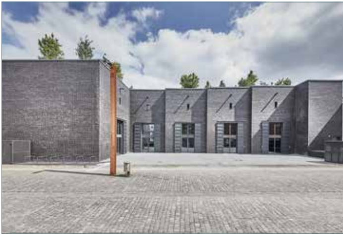
Mit wenigen Handgriffen können die Labore zum Vorhof geöffnet und die Arbeitsflächen zur Straße hin erweitert werden. Fotos: Architektur.dlx [2]
