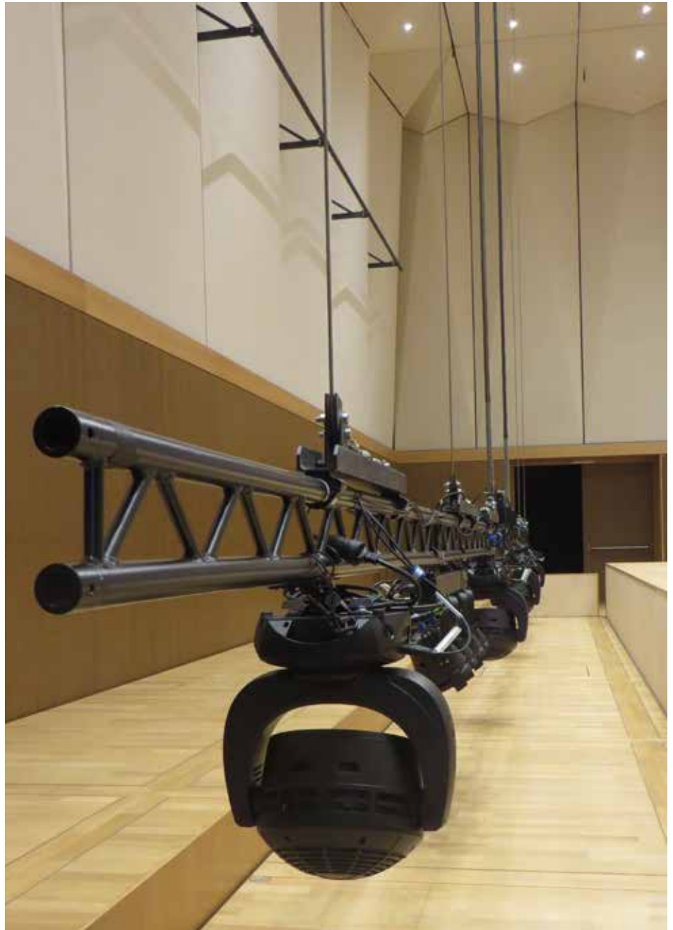
Drei Prospektmaschinenzüge im Großen Saal können als Beleuchtungszüge und für das Bewegen größerer Lasten und Aufbauten über der Bühne genutzt werden. Foto: David Klamroth
