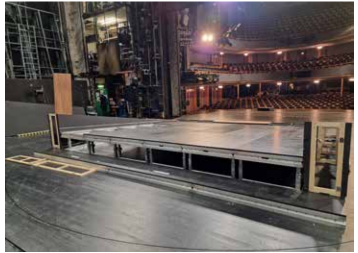
Teleskopierbare Podestfüße: Die Spielfläche des Kastens (hier noch im Bau) hat eine Steigung von 8,33 Prozent
