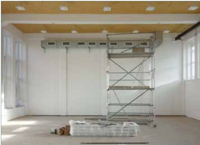
Der Malsaal wurde instandgesetzt und modernisiert, nun ist er funktional und hell. Fotos: Büro Voigt [2]
