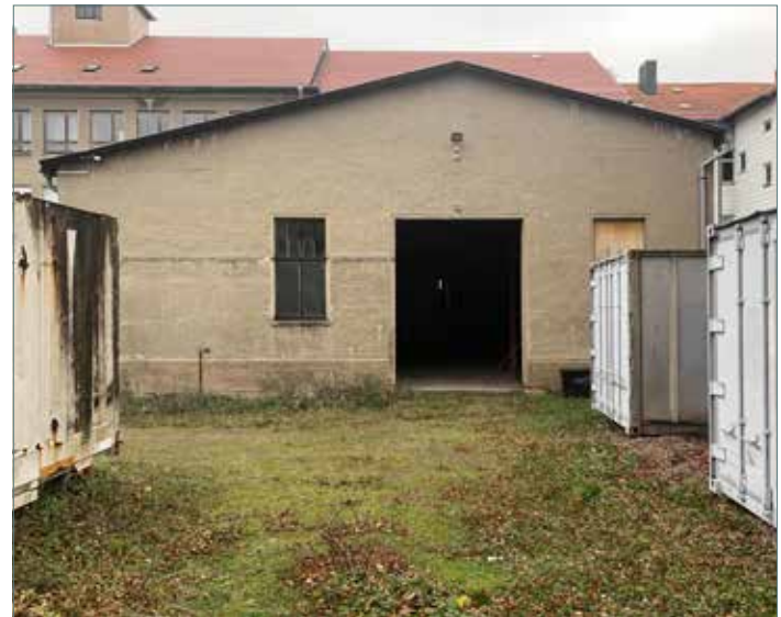
Der alte Fundus, Garagen und Schuppen auf dem Gelände wurden abgerissen, um Platz für den Neubau und einen vielseitig nutzbaren Hof zu schaffen
