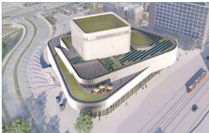
Herausforderung für Planung und Bau: die Asymmetrie des Gebäudes und die beengte Baustelle mit Straßen zu drei Seiten
