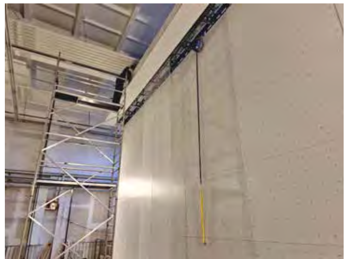
Testen des Wasserfalls: Hinsichtlich der Regenschienen ließen sich die Stuttgarter Werkstätten von einer externen Firma beraten. Foto: Olaf Lintelmann
